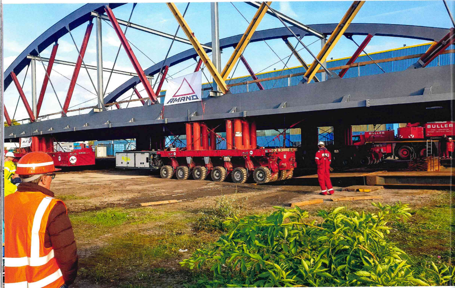
Auffahrt auf die Rampe zur Behelfsbrücke.
