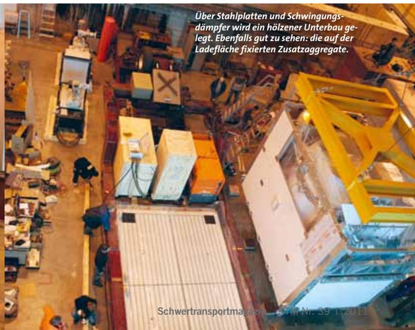
Über Stahlplatten und Schwingungsdämpfer wird ein hölzerner Unterbau gelegt. Ebenfalls gut zu sehen: die auf der Ladefläche fixierten Zusatzaggregate.
